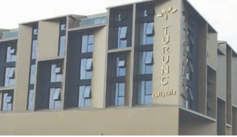
Turunç Otel Eskişehir
