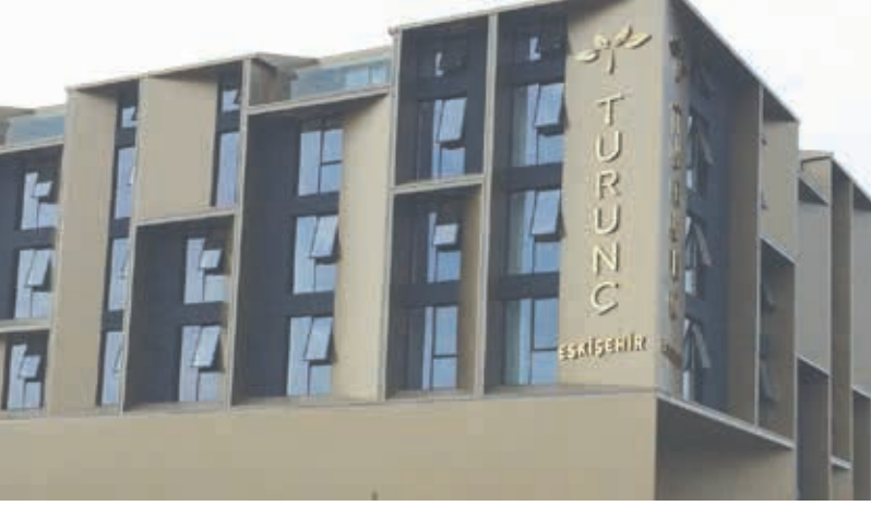
Turunç Otel Eskişehir
